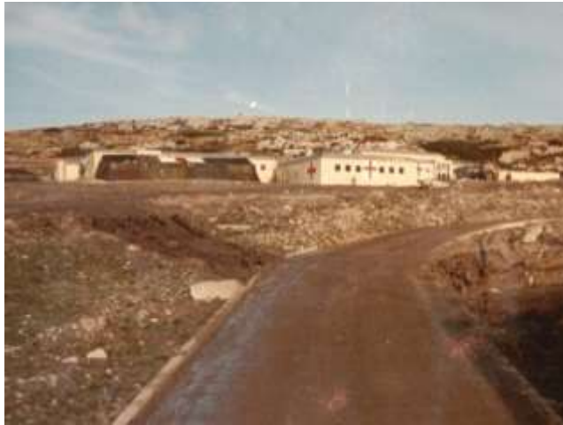
Vista panorámica del Hospital Militar Conjunto en Puerto Argentino
