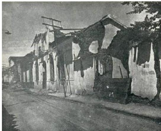
**Figura 5.** Grietas en construcciones de adobe, El Tocuyo
