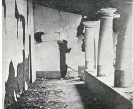
**Figura 4.** Paredes de bahareque (aun de mala construcción) con daños limitados, reparables hasta cierto punto y sin provocar su ruina inmediata.
